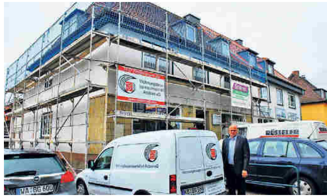
Die linke Hälfte dieses Wohn- und Geschäftshauses an der Bahnhofstraße hat die Baugenossenschaft erworben und lässt sie nun sanieren. Vorn im Bild: Geschäftsführer Volker Schultze. Foto: Armin Hass
